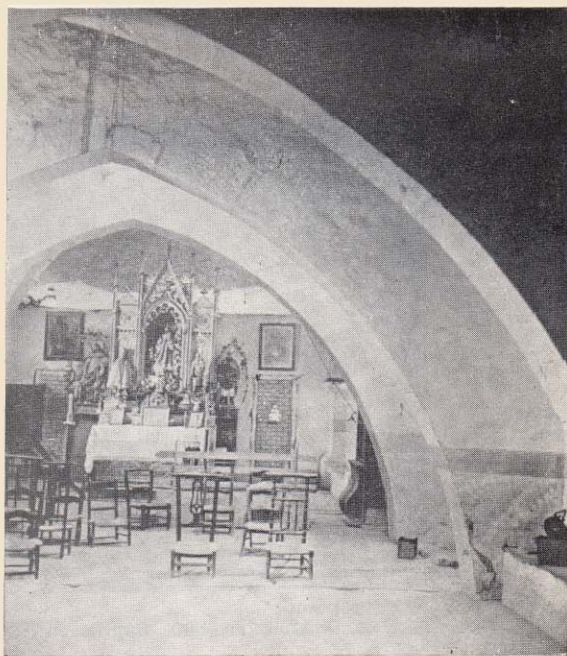
FOR. 23. — Barué. Santa Te. Interior (Foto Abbad)
